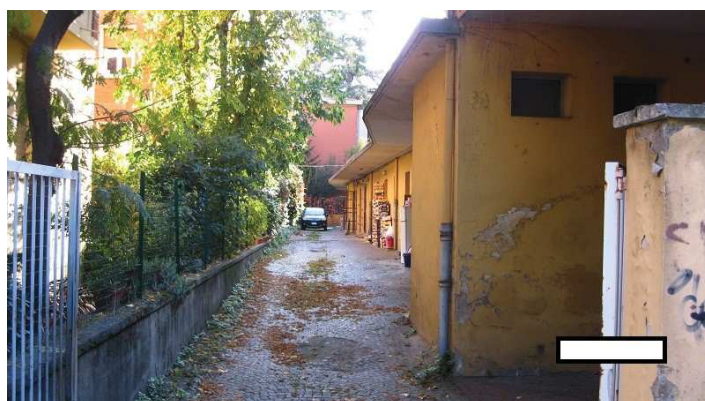
da via Mezzofanti accesso carrabile area ad est dell'edificio
