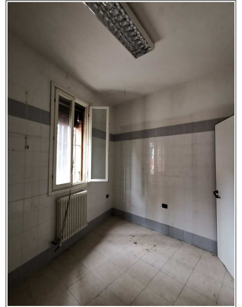
piano terra - vista interni
