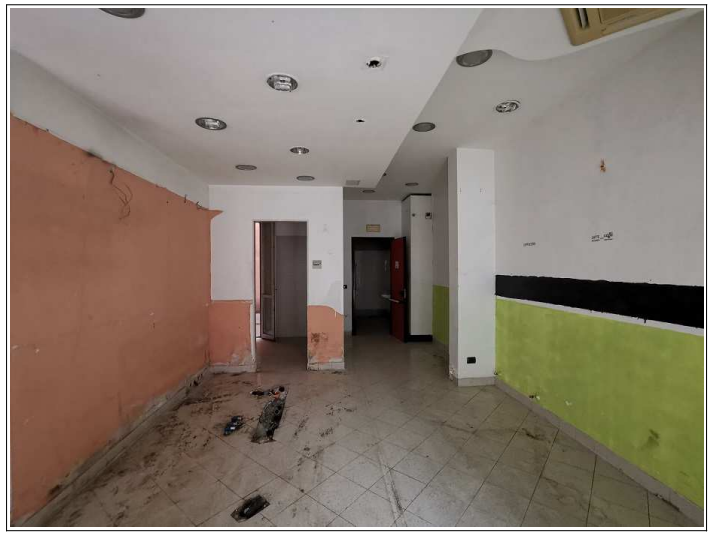
piano terra - vista interni
